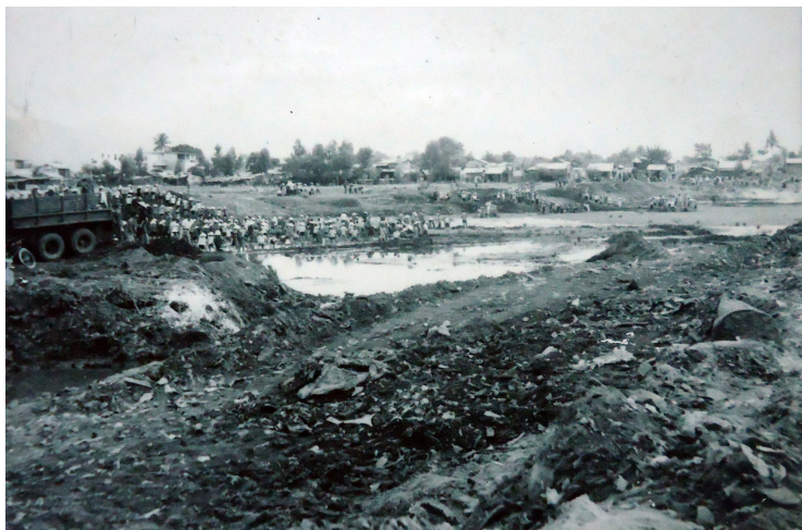
Khởi công công trình đại thủy nông Phú Ninh
